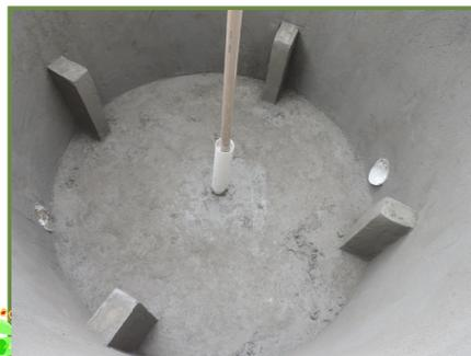
A segunda etapa do revestimento do cano de ferro guia é feita com um cano de PVC de 50 milímetros, com 3 metros de comprimento, que deve ser preenchido com massa de cimento.
