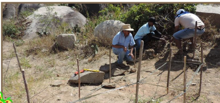
BBZ em construção. Área de arrasto ou saia do barramento Observam-se as estacas verticais e niveladas dos arcos montante e jusante.
