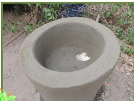
Dimensões: 80 centímetros de altura e diâmetro de 60 centímetros.
