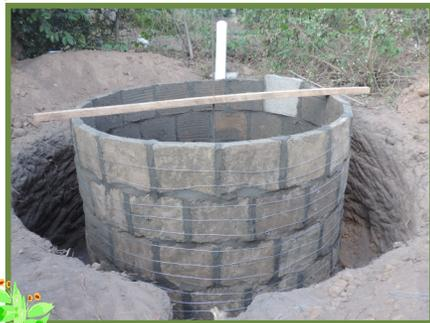
Reboque as paredes do tanque por dentro e também por fora, para evitar o contato direto do arame com a terra. A espessura do reboco deve ser, no máximo, de 2 centímetros, de forma a garantir que a caixa de fibra possa subir e descer livremente, sem encostar na parede.
