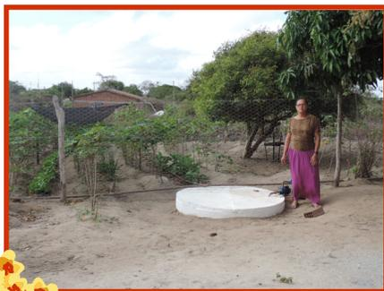
O tanque de estocagem de água é a unidade onde a água filtrada deverá ficar até ser bombeada para a caixa elevada e, posteriormente, chegar ao sistema de irrigação por gotejamento.
