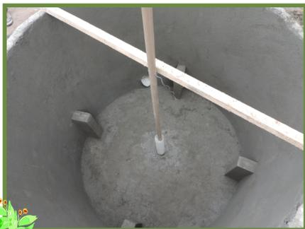
**Construção dos batentes:** depois de prontas às paredes, construa no fundo do tanque quatro batentes com altura de 60 centímetros. Utilize para cada batente 03 tijolos de 08 furos e mantenha uma distância proporcional um do outro. O objetivo dos batentes é evitar que a caixa de fibra encoste no fundo do tanque e feche as entradas e saídas de esterco da câmara de biodigestão.
