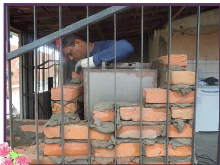
Na sequência, monte com tijolos o centro do fogão. Na altura da chapa, faça uma saída para a fumaça. Complete com areia o espaço onde será colocado o forno até a altura da rampa. Aplique este mesmo procedimento próximo à boca do fogão. Em seguida, preencha esse espaço com tijolos deitados e encaixados na areia, respeitando seu comprimento.
