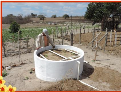
Dimensões do buraco para o tanque do filtro biológico: profundidade de 0,8 m, diâmetro de 2,20 m. O buraco deve ser maior, para permitir que o pedreiro possa se movimentar dentro dele, facilitando o processo de construção e a retirada das formas.
